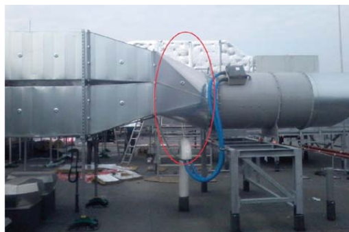
Rys. 4. Zdjęcie kształtki generującej duży dodatkowy opór nie przewidziany w obliczeniach – przykład 2
