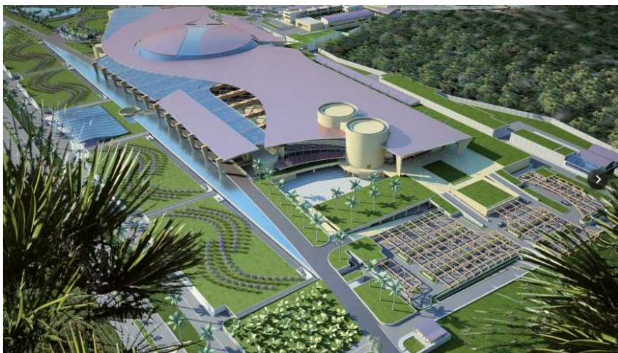
International Convention Center, Algieria, systemy ogniochronne konstrukcji
