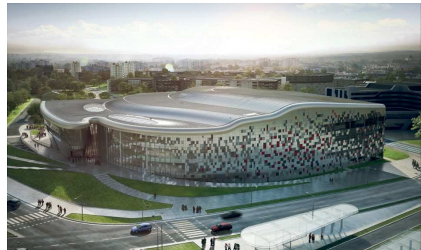
Centrum Kongresowe ICE, Kraków, zabezpieczenia ogniochronne konstrukcji i systemy oddymiania
